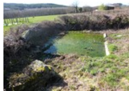
Lavoir Les Brechoux
