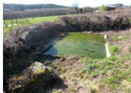
Lavoir Les Brechoux
